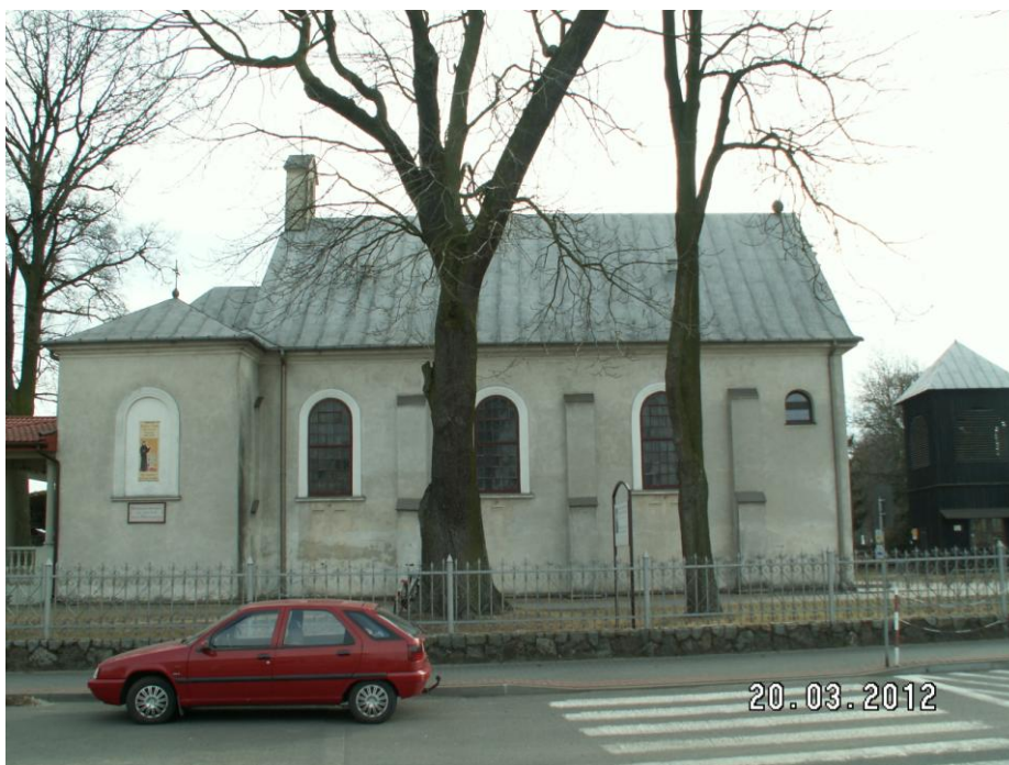
ryc. widok - najstarszej części kościoła, pokryty blachą cynkową
