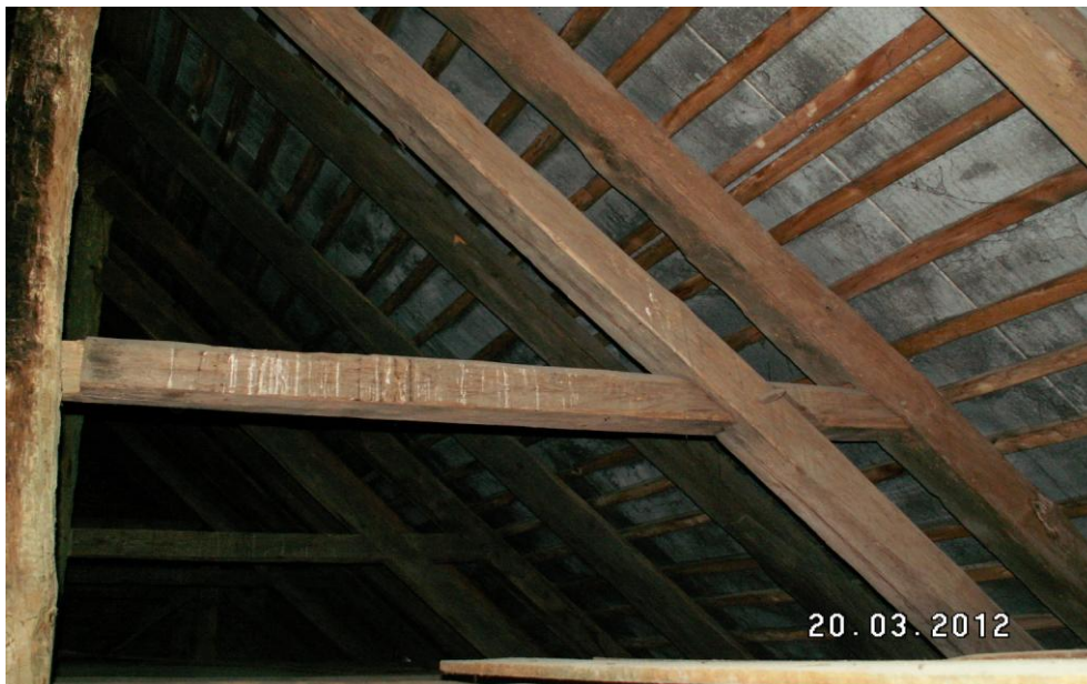
ryc. fragment konstrukcji stropu nad nawą główną - więzary wieszarowy nad nawą główną
